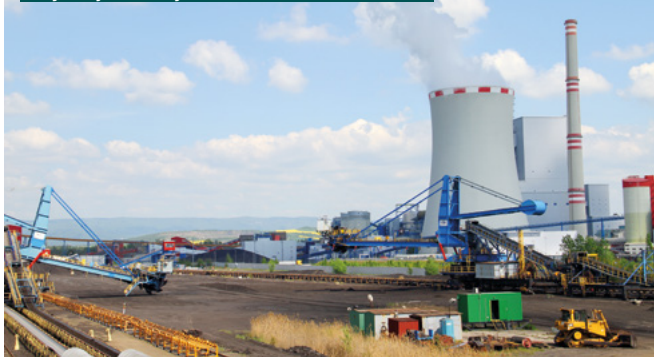
Nový zdroj Elektrárny Ledvice 660 MW v sousedství DB
